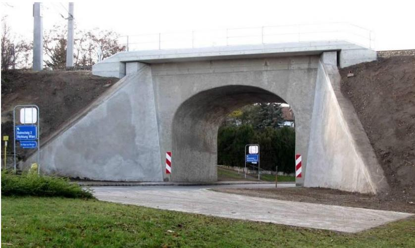
*2011 wurde die Teichstraßenbrücke umgebaut. Beidseitig verbreitern zusätzliche Überlager die Trasse. Der schadhafte Betonspritzer auf der ursprünglichen Ziegelverkleidung wurde abgeklopft, durch armierte Betonwände ersetzt und mit einer Abdeckung versehen. Insgesamt wirkt die Brücke jetzt wuchtiger und ist optisch vom ursprünglichen Entwurf mehr als weit entfernt.*
